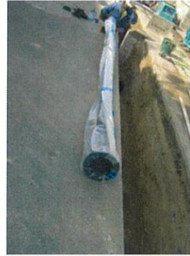
(受口処理) 据付前
