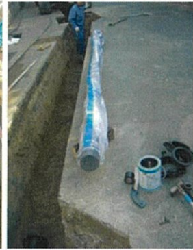
(挿し口処理) 据付前
