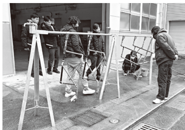
水圧による漏水検査
